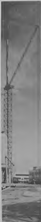
307-ft. DERRICK CRANE. GRUA DI 307 pia haltu.
